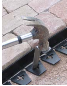
Luja kiinnitys asennusnauloilla
