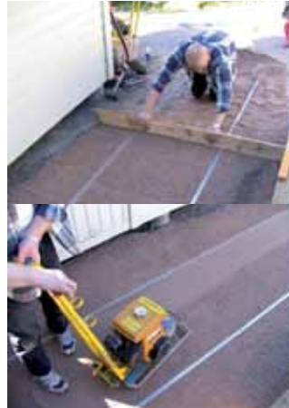
3 Lisää kivituhkaa niin, että pohja on tasainen. Tiivistä huolellisesti.
