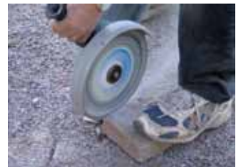
8 Leikkaa vajaaksi jäävät kivet ja asenna ne paikoilleen.
