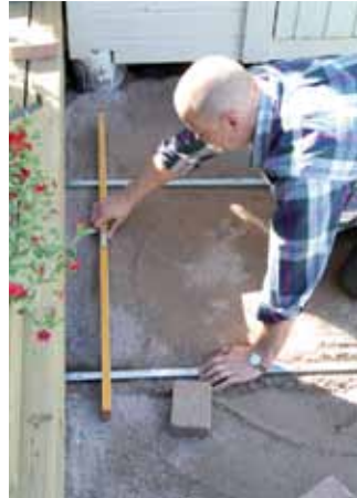
2 Käytä esim. metalliputkia ohjureina pohjan tasaamisessa. Käytä vatupassia apuna.
