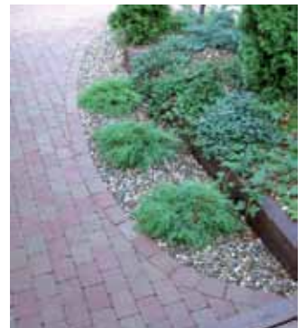
12 Lopuksi täytetään reunuksen ulkopuolinen osa esim. mullalla ja istutetaan kasvit.
