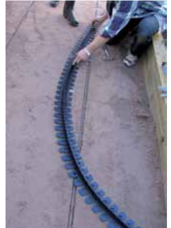
4 Kiinnitä asennusnauloilla taipuisa reunatuki kiveyksen ulkoreunoille.
