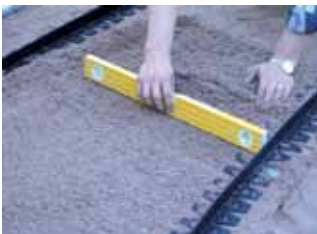
5 Levitä ohut kerros asennushiekkaa.
